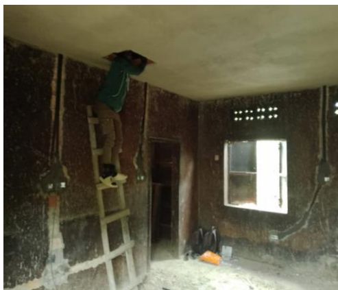
内部の補修作業
