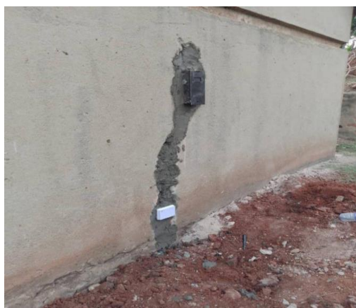
外壁の補修作業
