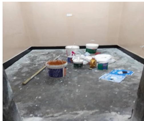
内壁の塗装後
