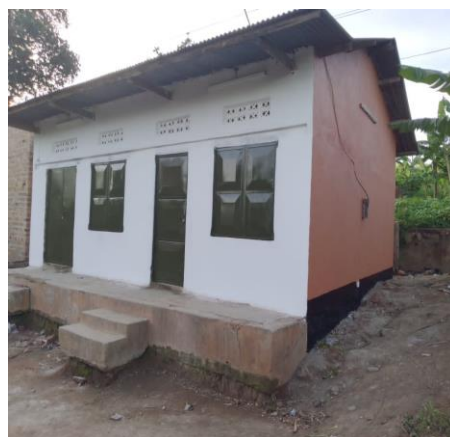
外壁の塗装後
